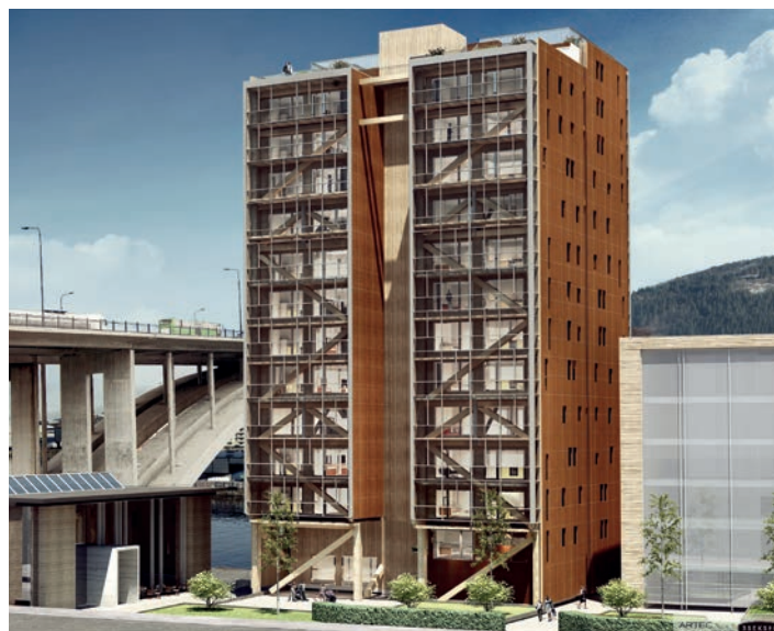
Il "Treet" di Bergen, in Norvegia, l'edificio in legno più alto del mondo – 52 metri di altezza e 14 piani. Teknos sta fornendo TEKNOS FR Façade e TEKNOS FR Panel
